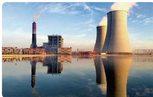
华能山东如意(巴基斯坦)萨希瓦尔燃煤电站项目
