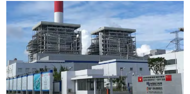
越南永新燃煤电厂一期项目
